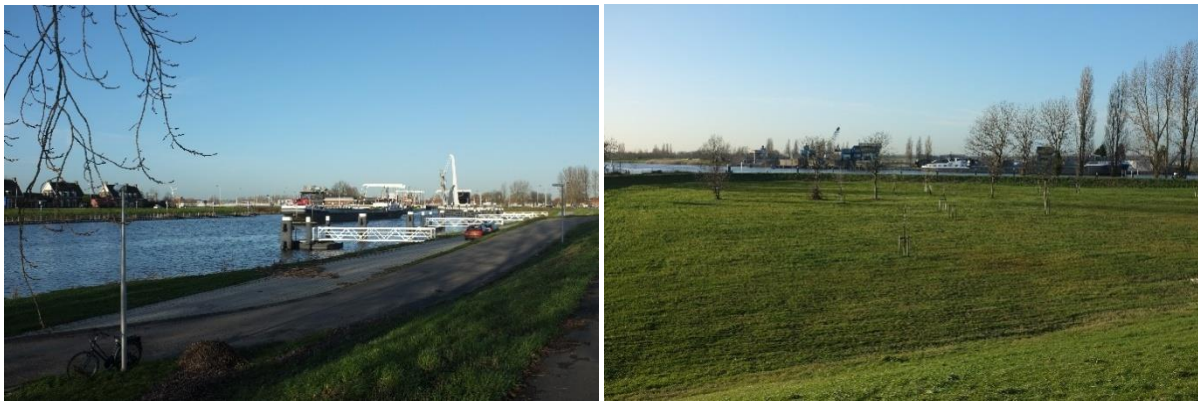
Figuur 2.12: Sluiseiland: foto links bestaande kade met Julianasluis op de achtergrond, rechts, mogelijk te benutten grasland voor terminal.
