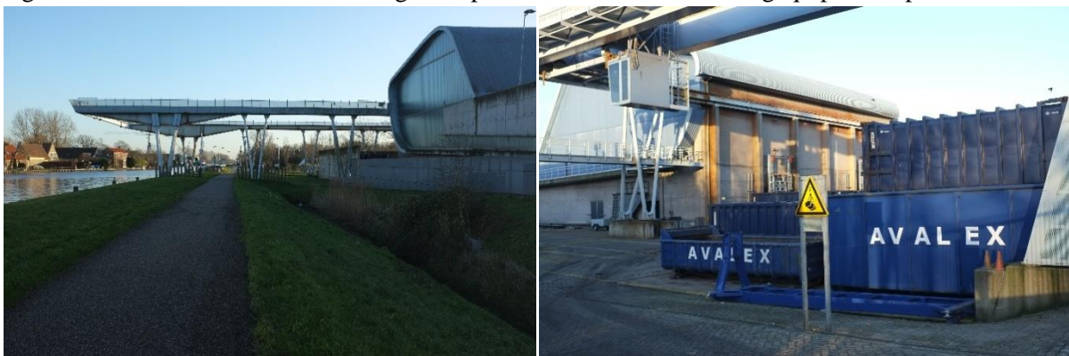
Figuur 2.15: Avalex: containerafvallogistiek per binnenvaart met overslagequipment op maat
