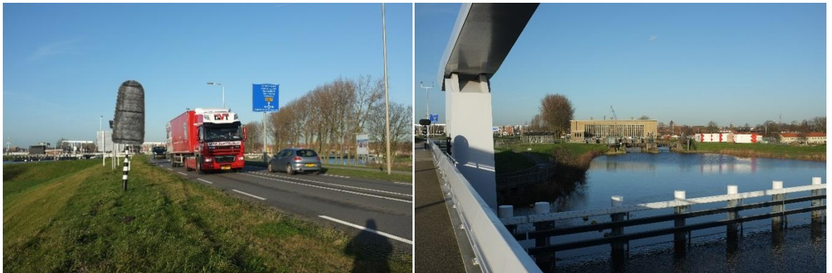
Figuur 2.12: Sluiseiland: foto links: Sluiseiland wordt doorsneden door N207 en heeft daardoor een uitstekende bereikbaarheid zowel over weg als water, rechts: woonbebouwing op ongeveer 200 meter.
