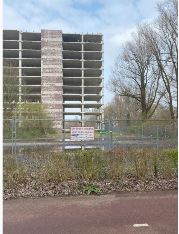
Figuur 12: Casco gebouw in Entree, “het skelet”
