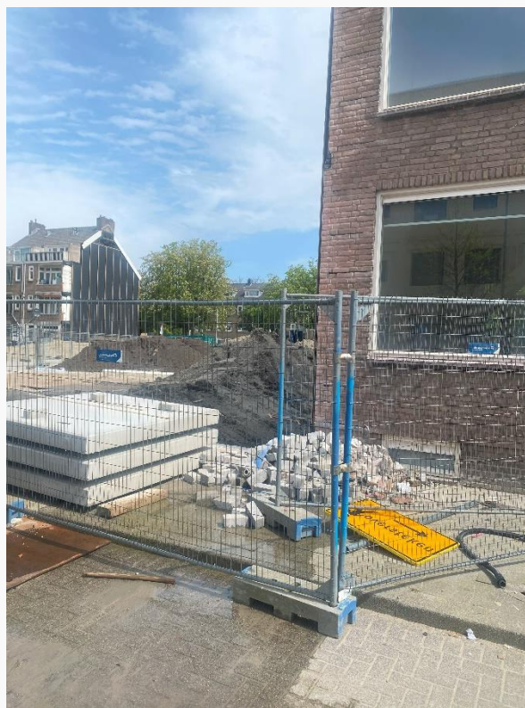
Figuur 36: Leegstand en sloop in Carnisse
