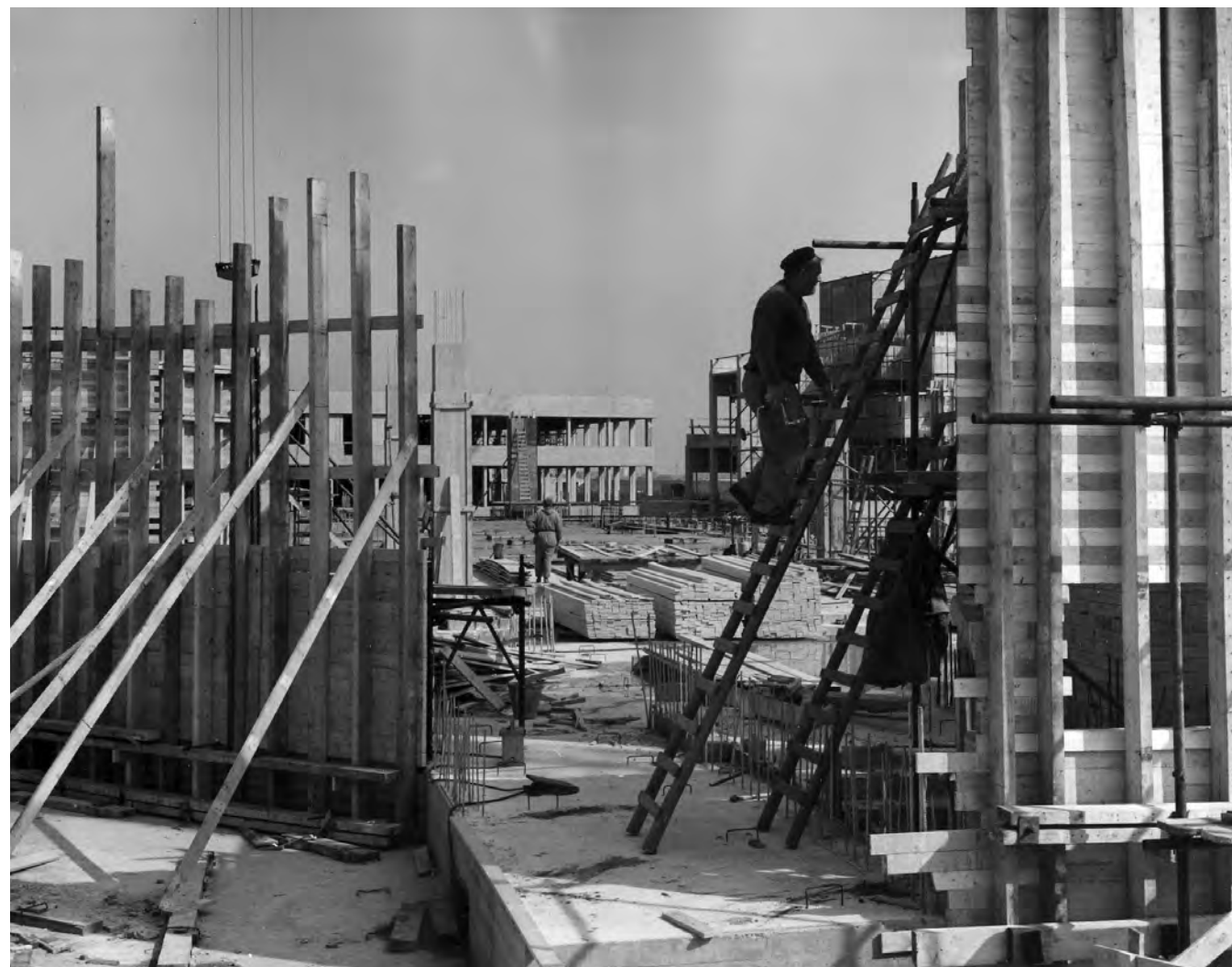
bekisting tijdens de bouw, foto 25 april 1967
