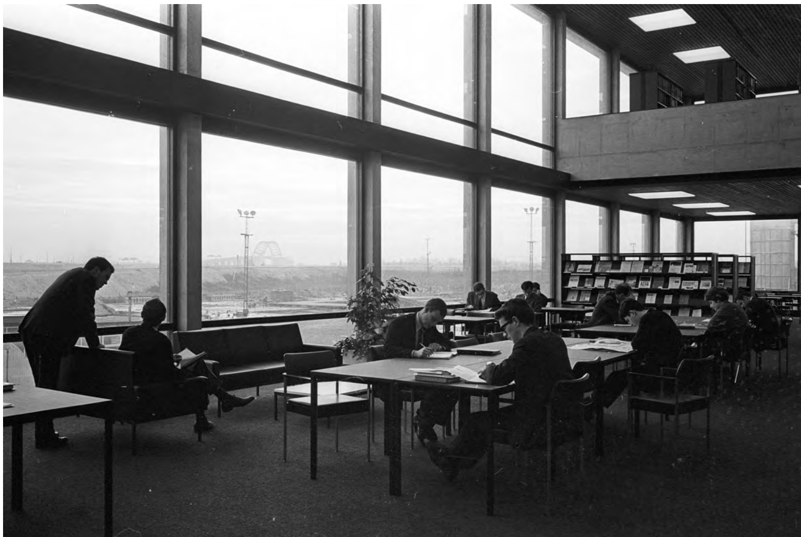
leeszaal begane grond aan oostgevel, foto Tom Kroeze 1970
