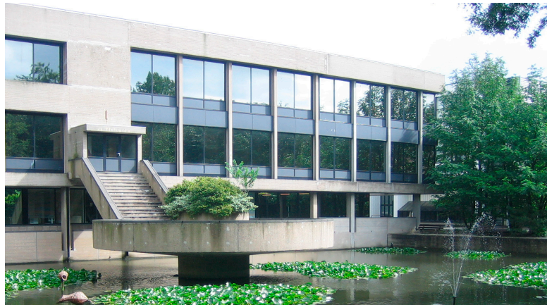
Eerste generatie, B-gebouw: voorbeeld van sprekende gevelarchitectuur, natuurlijke materialisering en terughoudende kleurstelling
