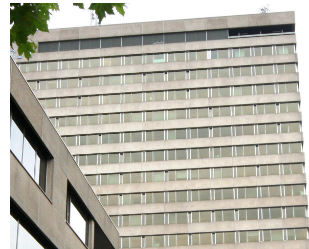
Sprekende gevel: H-gebouw, Elffers, campus Woudestein, Rotterdam: Ramen zijn ondergeschikte elementen, horizontale lijnvoering geaccentueerd, reliëf in gevelvlak
