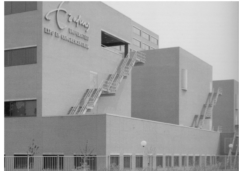
Tweede generatie, M-gebouw: minimale interactie tussen gebouw en omgeving, gesloten gevels en onuitgesproken materialisering, achterkant naar A. van Rijckevorselweg
